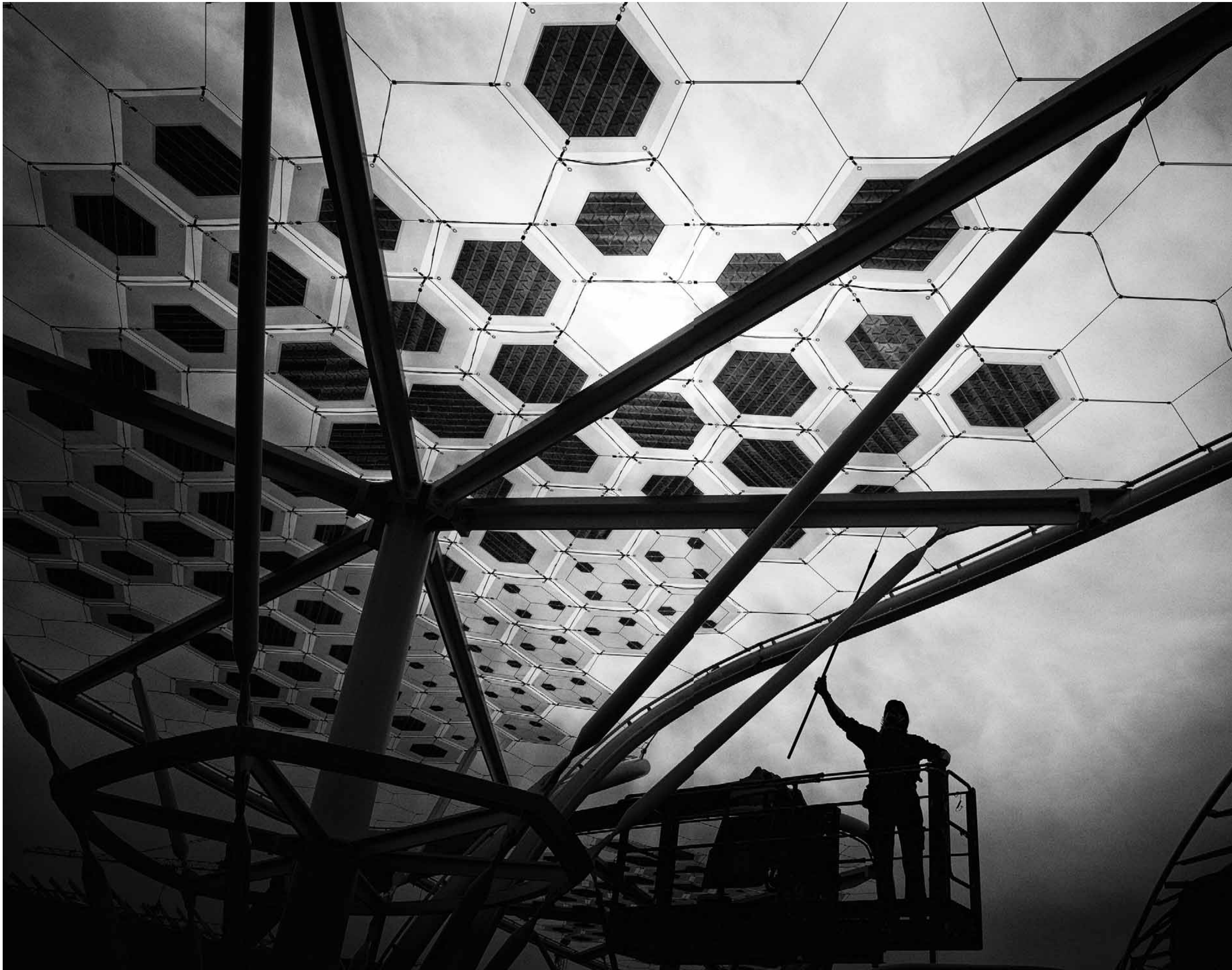
Letzte Handarbeit: Ein Arbeiter streicht die Stahlkonstruktion am deutschen Pavillon.
