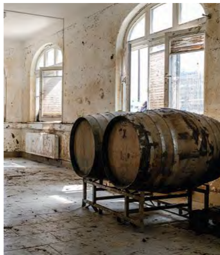
Dörte Näkel (rechts) und ihre Schwester Meike vom Weingut Meyer-Näkel in Dernau an der Ahr haben noch mit den Folgen der Flut zu kämpfen. Ende Juli waren auch im Weingut Adeneuer viele Räume und Fässer komplett verschlamm.
