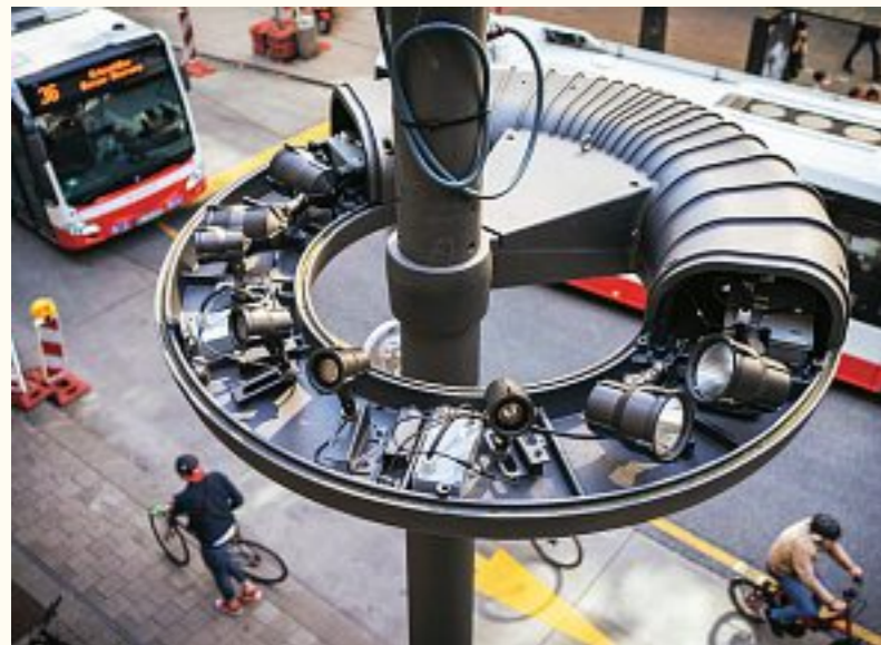
Im Leuchtenkopf: Auf einer Plattform gibt es Strahler für die Fassadenbeleuchtung (oben) und nach unten gerichtete Strahler für Straße, Fußgänger und besondere Events.
