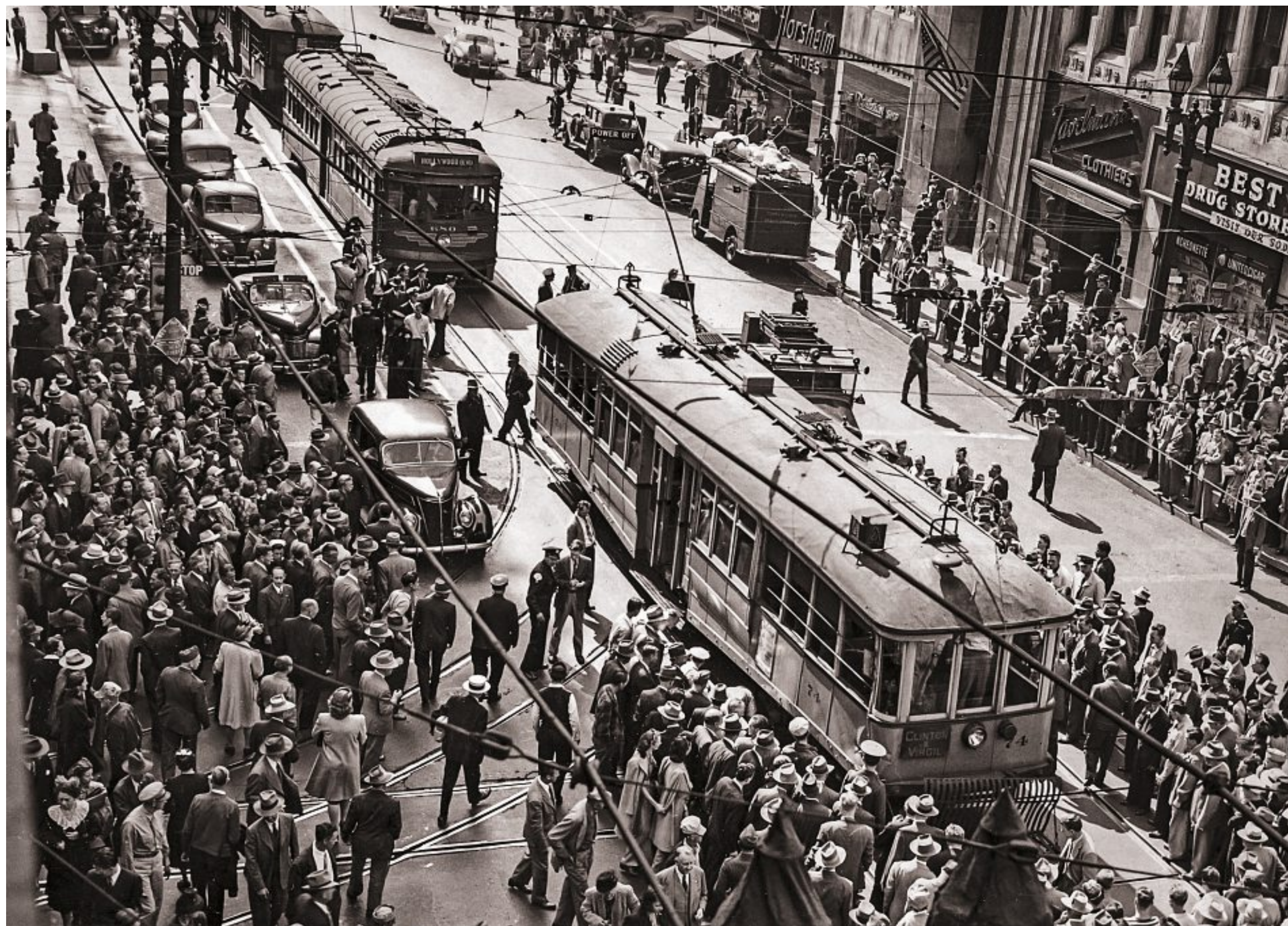
Kein Durchkommen mehr: In den dreißiger und vierziger Jahren kamen sich Autos, Busse und Bahnen wie hier im Zentrum von Los Angeles zunehmend in die Quere.
