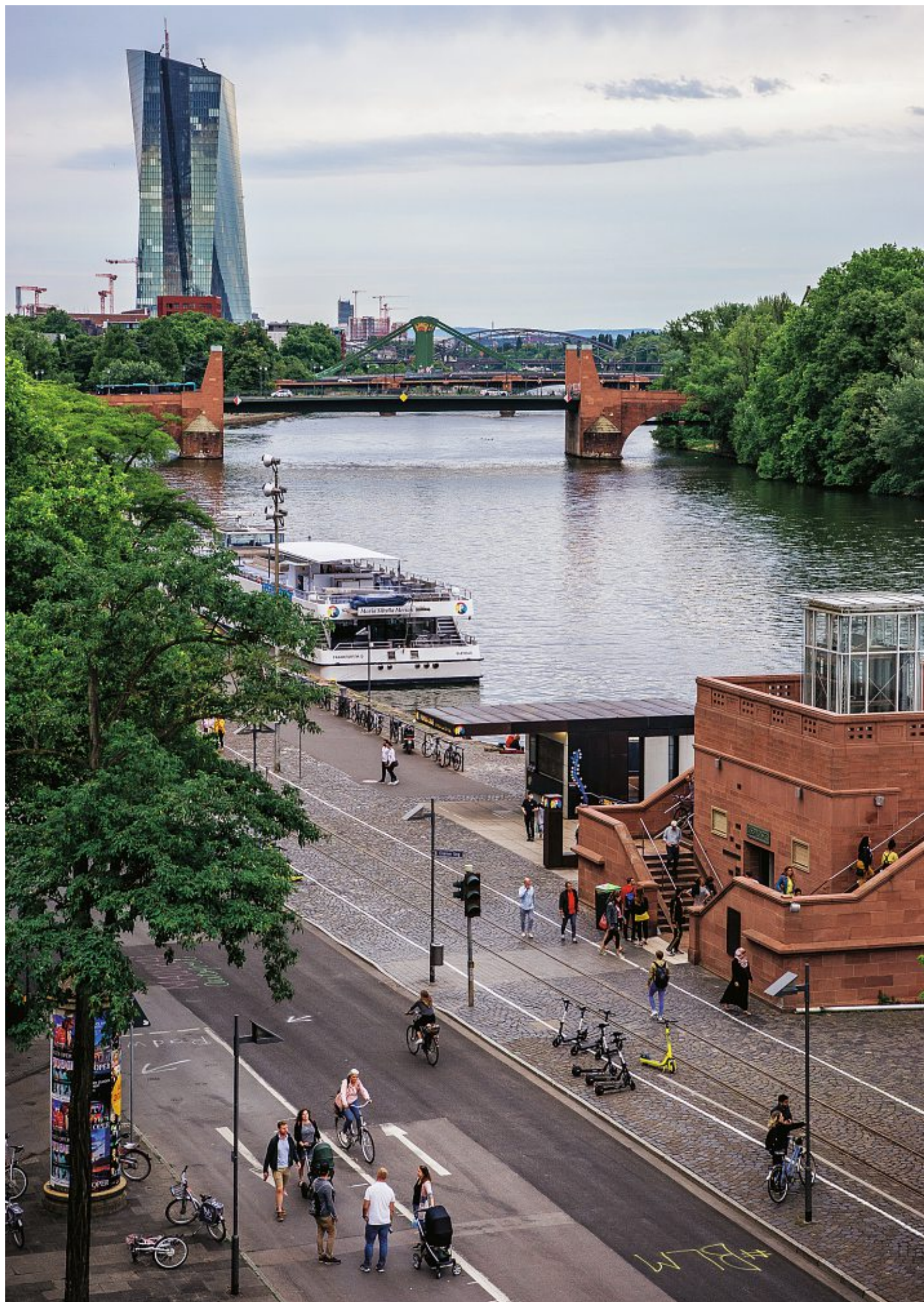
Das nördliche Mainufer: Seit einem Jahr gibt es hier mehr Platz für Fußgänger und Radfahrer. Vom 1. September an dürfen wohl wieder Autos auf der Uferstraße fahren.
