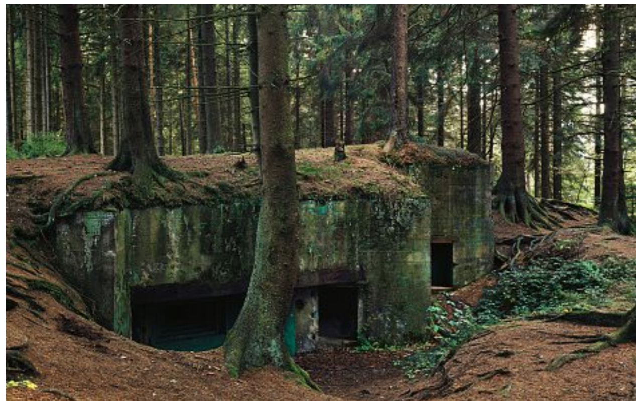
Gruppenunterstand mit Kampfraum: Auch Bunker 132 des Westwalls war vor 75 Jahren umkämpft.
