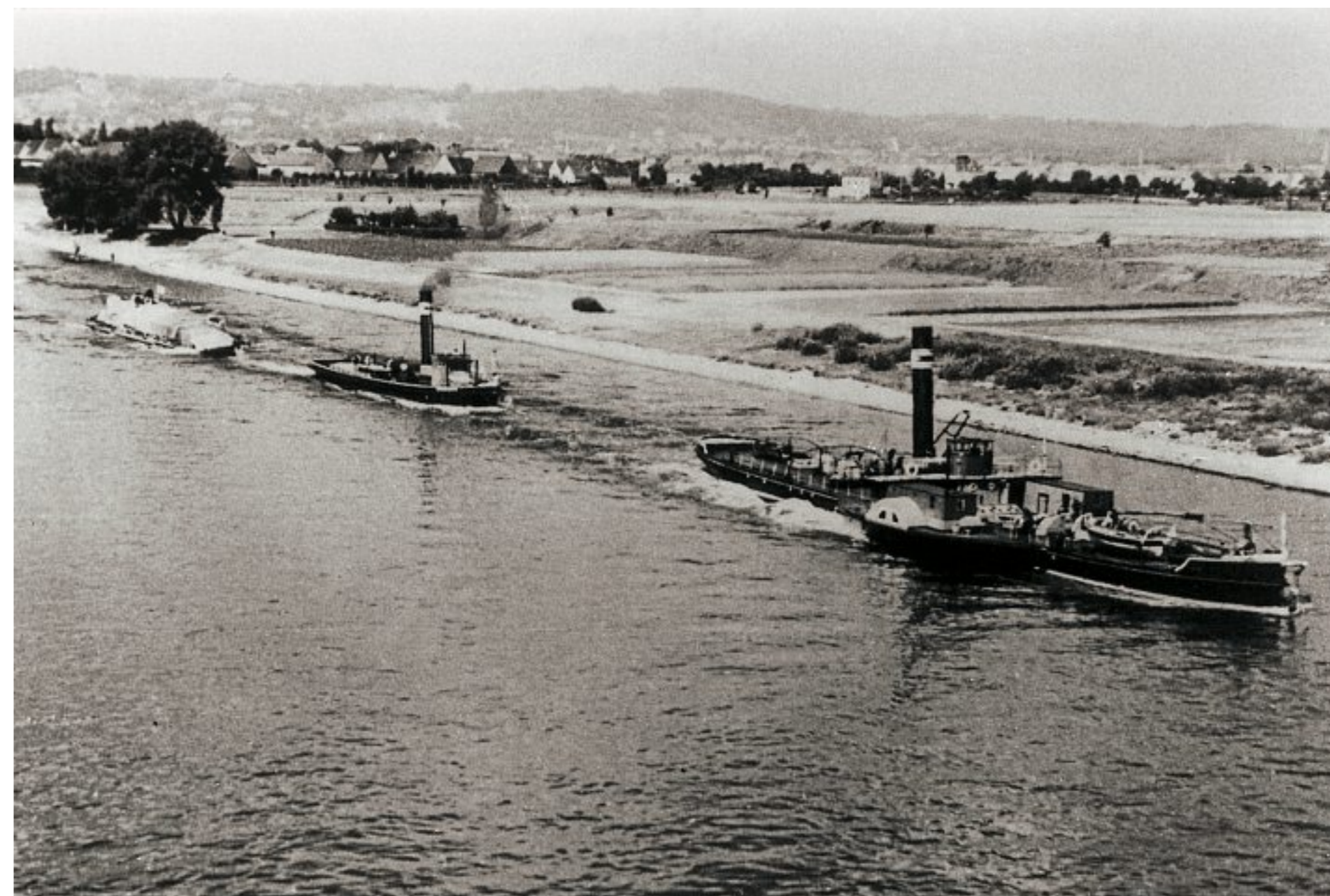
Im Schlepp: Mit gewaltigem Aufwand wurden 1942 sechs U-Boote von der Ostsee ins Schwarze Meer gebracht – hier der Transport über die Elbe bei Kaditz, kurz vor Dresden.
