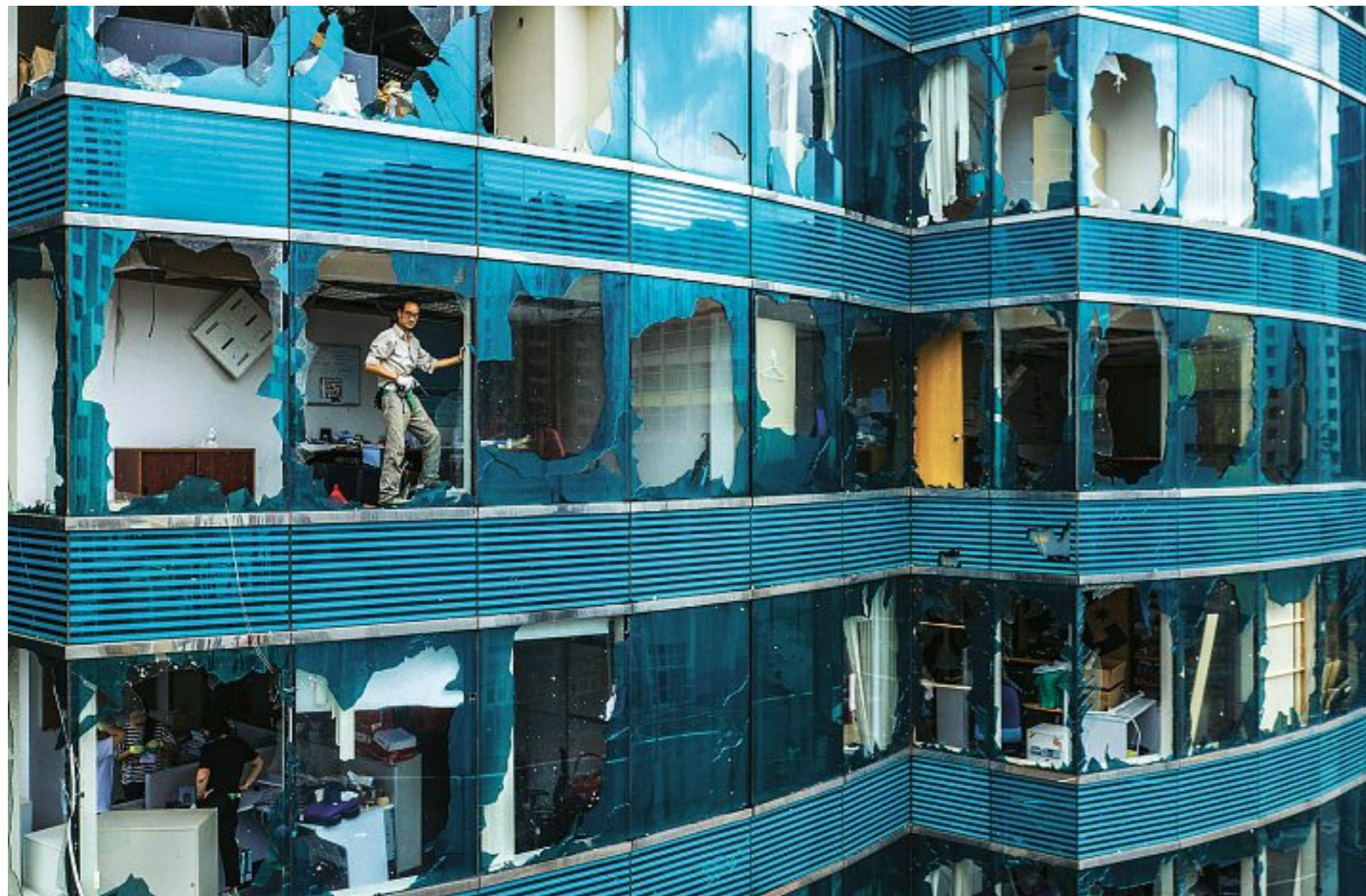
Spur der Zerstörung: Über ein Bürogebäude in Hongkong ist der Taifun Mangkhut hinweggezogen. Auf den Philippinen kamen bei dem Wirbelsturm mehr als zwei Dutzend Menschen ums Leben.
