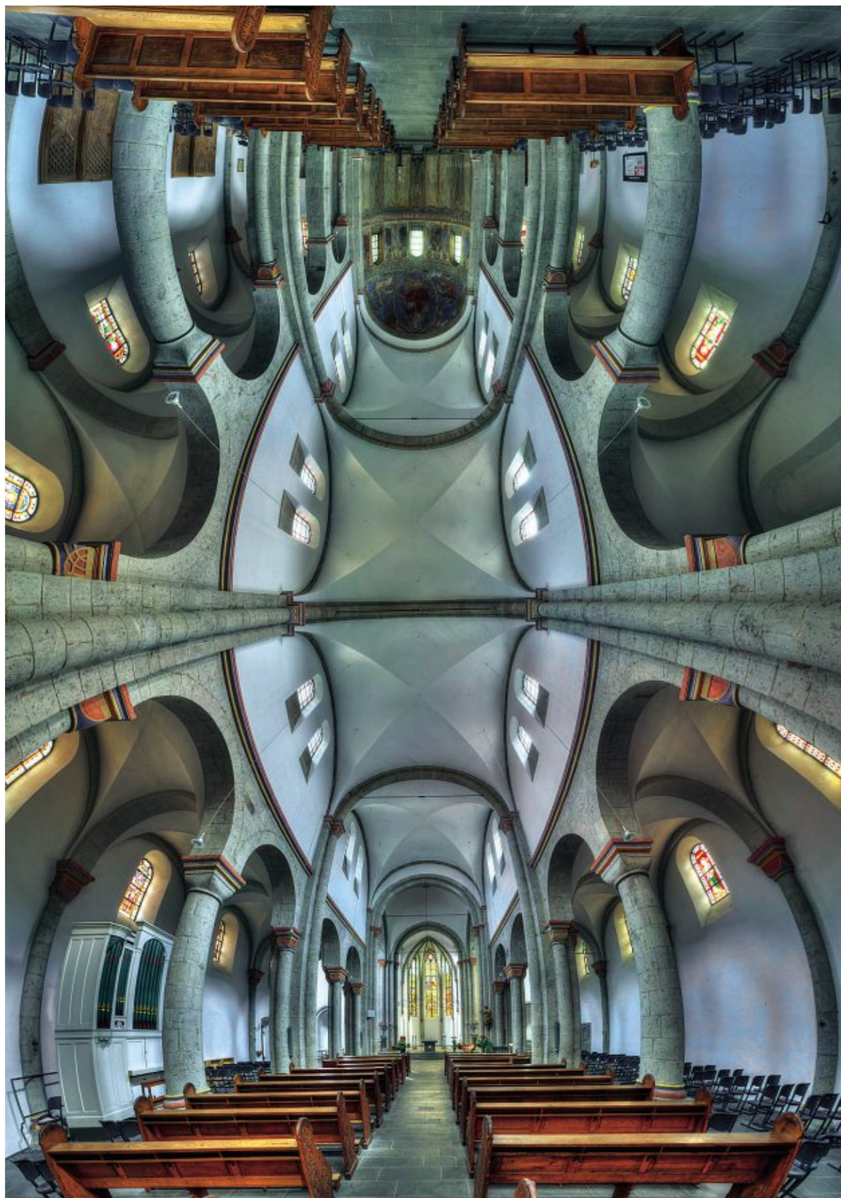
Knechtsteden, Stadt Dormagen: Klosterbasilika St. Andreas Die Klosterkirche der 1130 gestifteten Prämonstratenserabtei wurde in zwei Bauabschnitten (1138–1151/1151–1181) im romanischen Stil als dreischiffige, doppelböhrige Gewölbekirche mit
