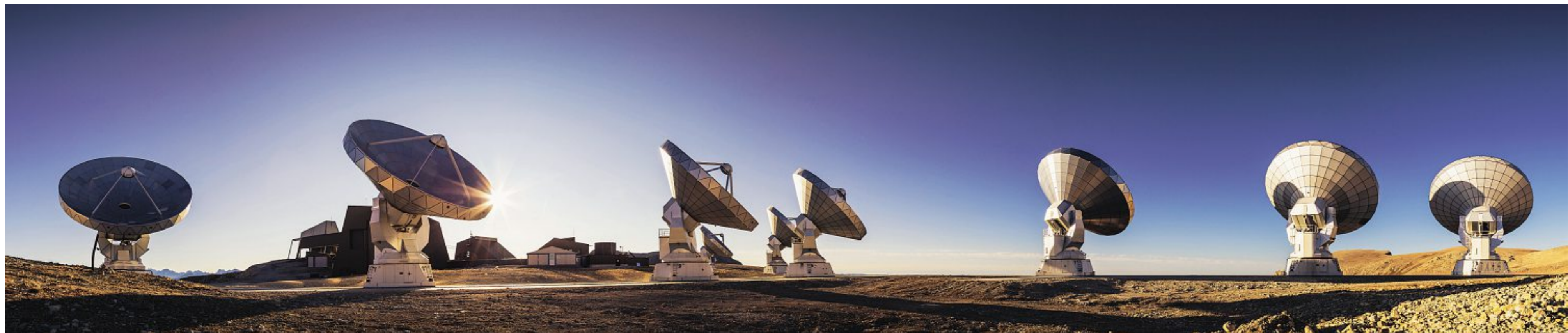
Auf Schienen unterwegs: Die jeweils 125 Tonnen schweren Antennen mit den Schalen von 15 Meter Durchmesser lassen sich in verschiedene Konfigurationen bewegen.
