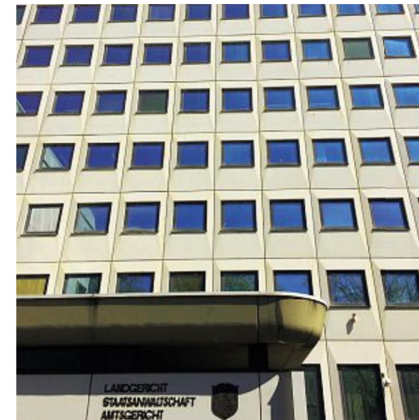
Viel besser, als man glaubt: Das alte Gerichtsgebäude soll demnächst abgerissen werden.
