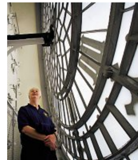
Metallskelett und Glas: Die sieben Meter großen Zifferblätter wiegen jeweils vier Tonnen.
